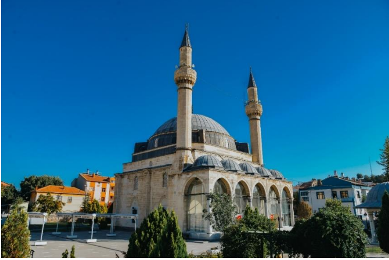
Sultan Selim Camii genel görünümü
